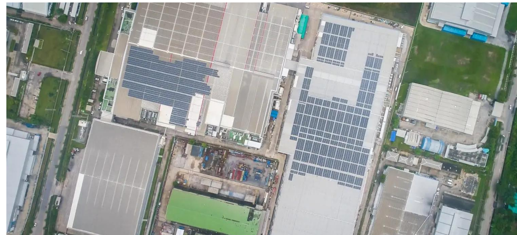
■ 泰国Unicharm 6MWp光伏项目 UNICHARM Thailand 6MWp Rooftop PV Project
