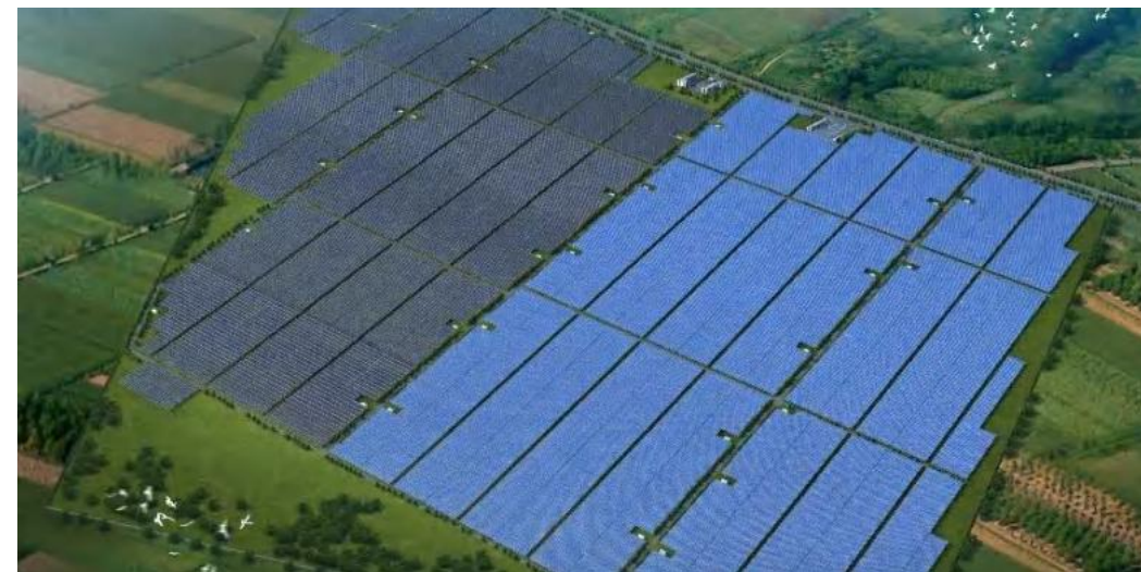
■ 越南HCG&HTG 100MWp光伏电站 Vietnam HCG&HTG 100MWp photovoltaic power station
