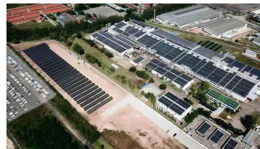
■ 泰国SIG Combibloc 3.3MWp光伏项目 Thailand SIG Combibloc 3.3MWp PV project
