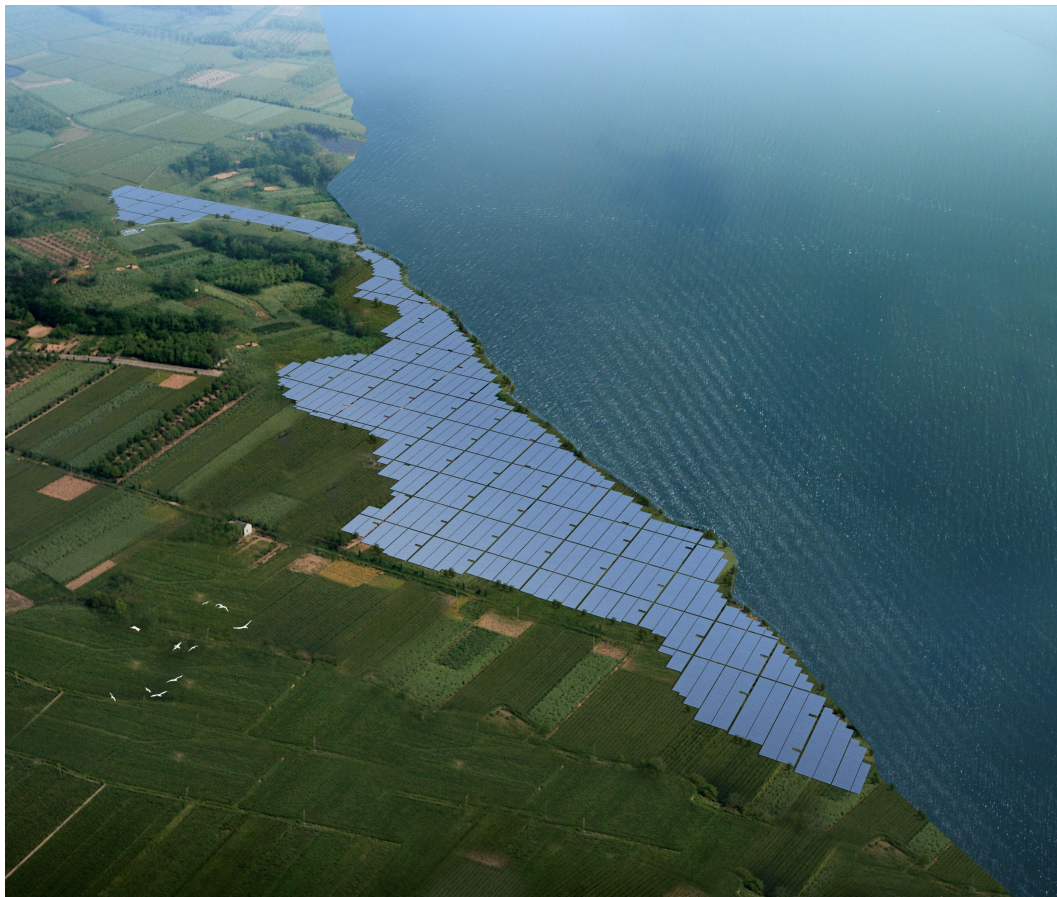
■ 越南油汀 500MWp光伏项目 Vietnam Yau Ting 500MWp PV project
