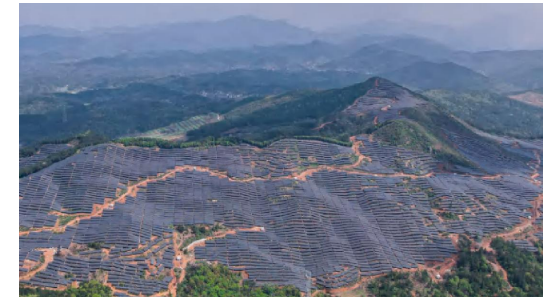
■ 大唐江山吕岗68MWp光伏项目 Datang Jiangshan Lugang 68MWp photovoltaic project
