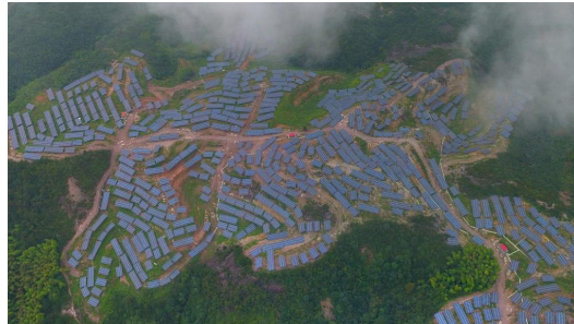
■ 衢州市衢江区“光伏小康工程”110MW 光伏电站项目 Quzhou City "PV Xiaokang Project" 110MW PV project
