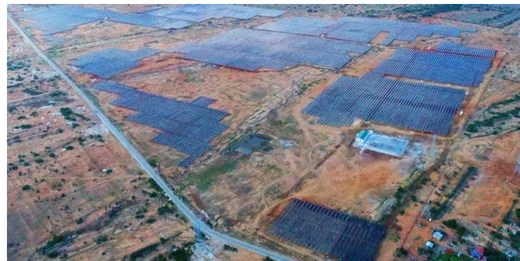
■ 越南ADANI 50MW福明光伏项目 Vietnam ADANI 50MW Fuming photovoltaic project
