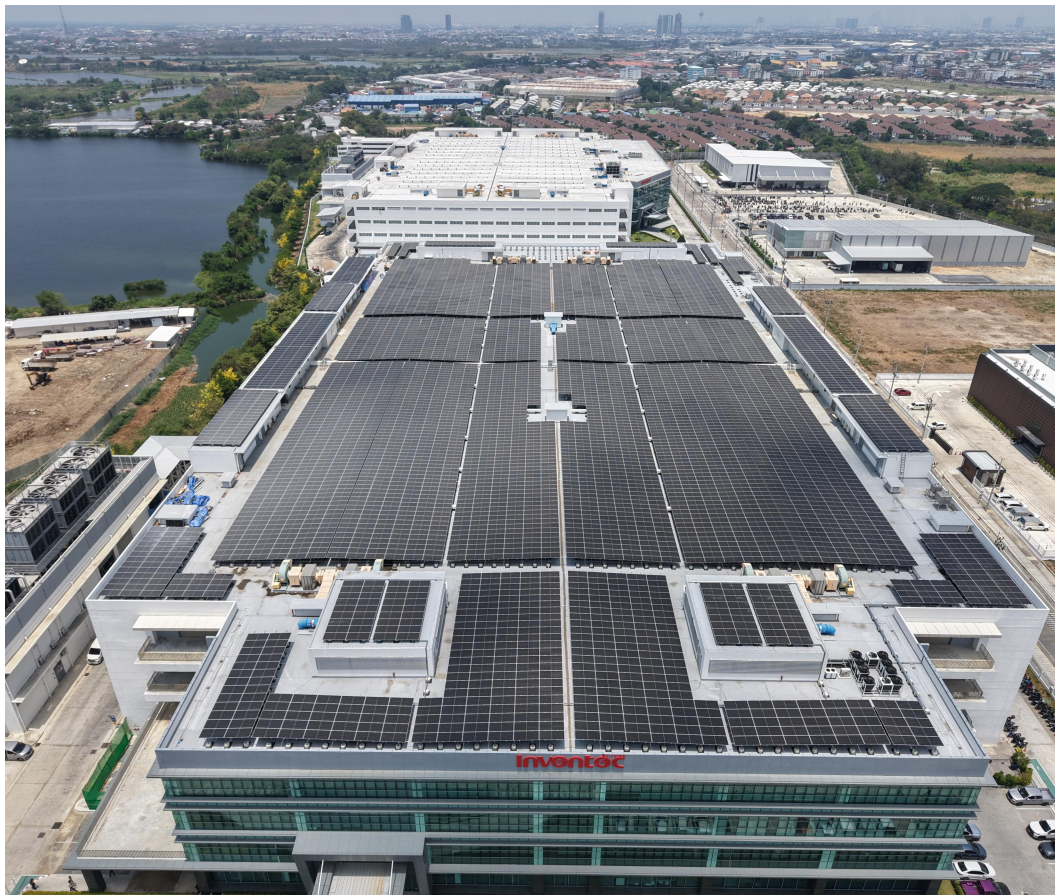
■ 泰国英业达电子（泰国） 3.7MWp光伏项目 Thailand Inventec Electronics(Thailand) Industrial Park 3.7MWp PV project
