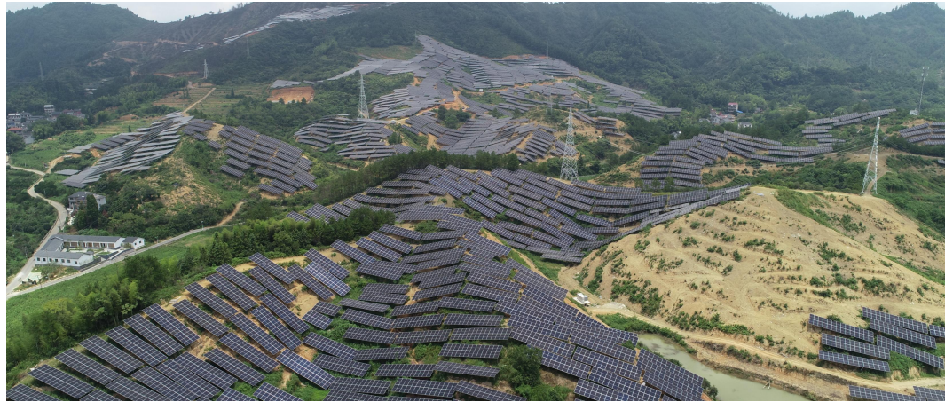
■ 衢州常山100MW 农光互补项目 Quzhou Changshan 100MWp Agriculture PV Project
