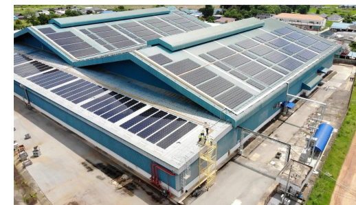
■ 泰国Dole 3.7MWp光伏电站 Dole Thailand 3.7MWp Rooftop PV Project
