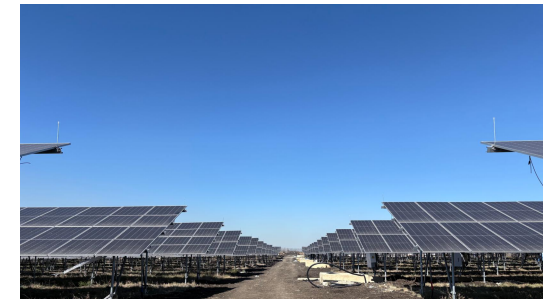
■ 南非豪登3.5MW/4MWh光伏项目 (一期) South Africa Gauteng 3.5MW/4MWh PV Project (Phase I)
