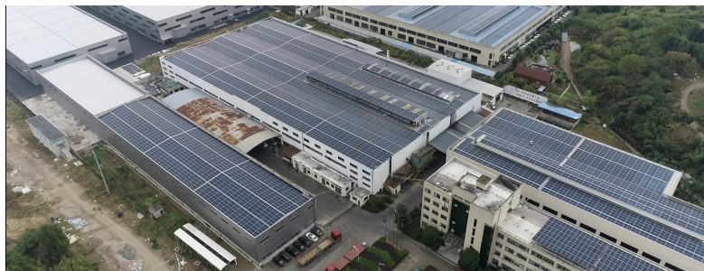
■ 绍兴嵊州万力铜业5MW光伏项目 Shaoxing Shengzhou Wanli Copper 5MW PV Project
