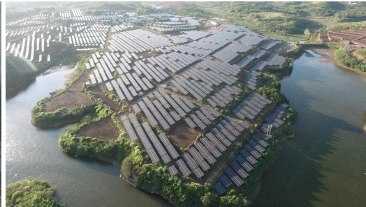
■ 中电工程浙江衢江周家乡 30MW农光互补光伏发电项目 Zhejiang Qujiang 30MWp Agriculture PV Project
