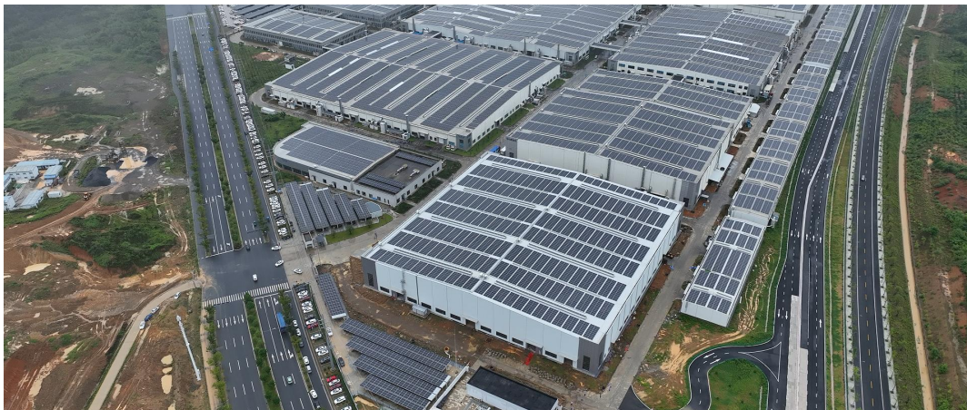
■ 安徽中鼎减震橡胶20MW光伏项目 Anhui Zhongding 20MWp Rooftop PV Project
