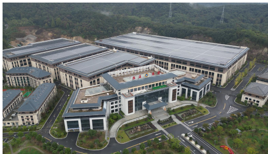
■ 萧山叁益集团圆融科技6.6MWp光伏项目 Hangzhou Xiaoshan Sanyi Group 6.6MWp PV Project
